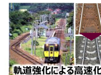
軌道強化による高速化
