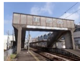
既存施設の 撤去
