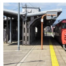
駅舎・ホーム改修
