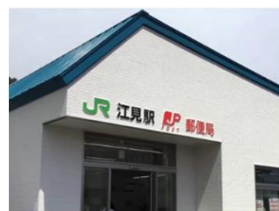
駅舎の 新改築・移設
