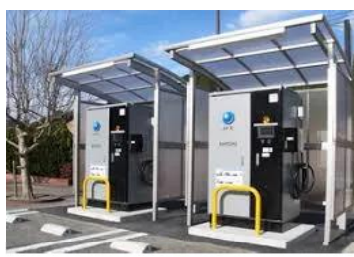
EVバス充電施設の設置
