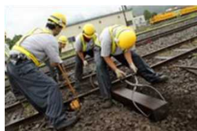
鉄道施設の修繕
