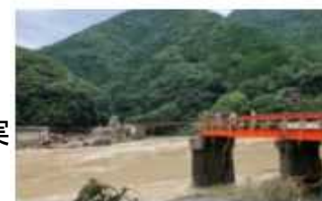
橋梁流失（熊本県道 深水橋）
