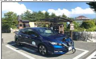
<道の駅でのEV充電器の設置>
