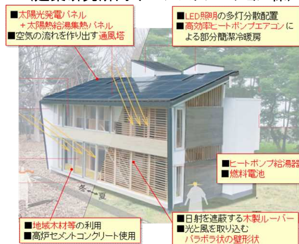
LCCM住宅の例 (建築研究所内 デモンストレーション棟)
