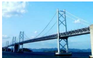
本四連絡橋(瀬戸大橋)
