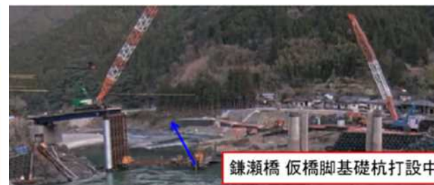
仮橋設置工事(R3.2)
