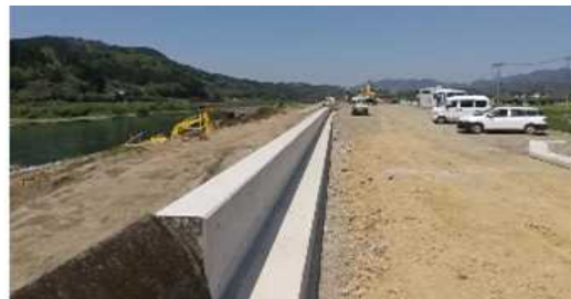
堤防損壊復旧工事(R3.4)
