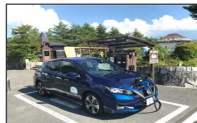
< 道の駅でのEV充電器の設置 >
