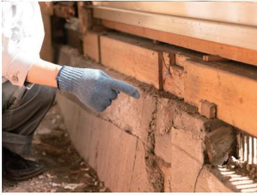
床下の換気が不十分で湿気により土台が腐朽してきた。
