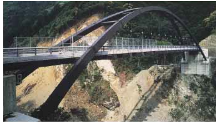
橋橋(熊本県) 耐候性鋼材を使用した鋼橋
