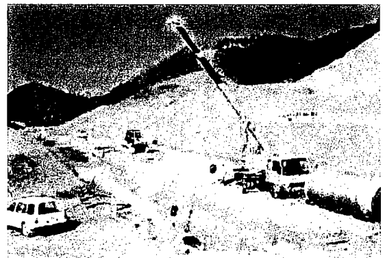
施工状況(他工事)
