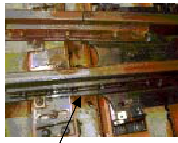
分岐器と一般区間のレールの高剛性接着継手
