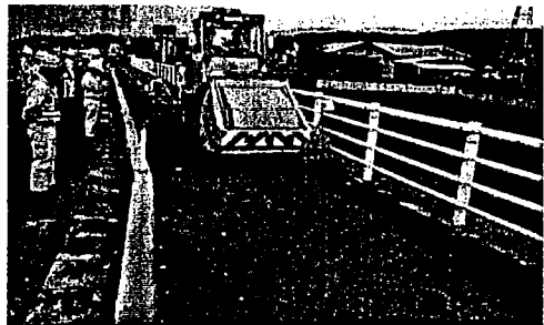
歩道清掃状況
