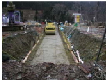
図-2 砂防ソイルセメント締め固め状況
