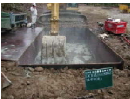
図-1 砂防ソイルセメント混合状況
