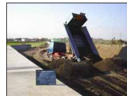
道路事業 安価な盛土材の確保
