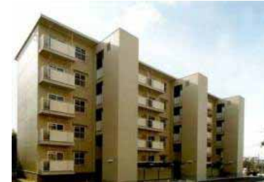
（エレベーター設置後）
