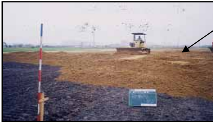
敷砂工法(サンドマット工法)
