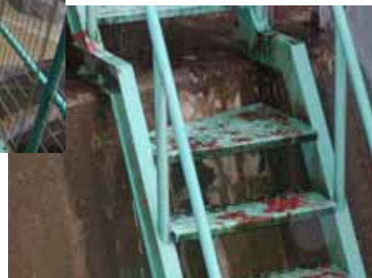
経年劣化による 腐食、発錆
