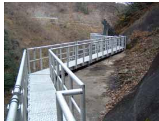
H16：ヒレット階段、右岸歩廊部施工
