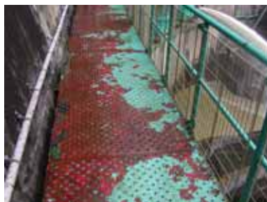
経年劣化による 腐食、発錆
