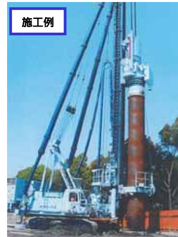
鋼管ソイルセメント杭の施工
