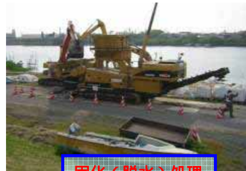
固化（脱水）処理
