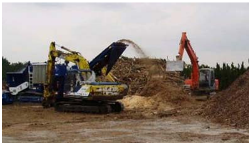
チップ化作業状況
