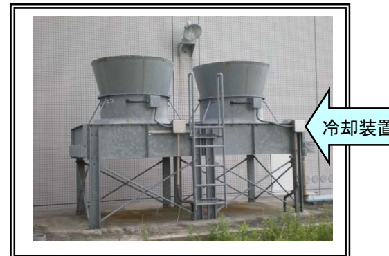
ラジエター式冷却方式
