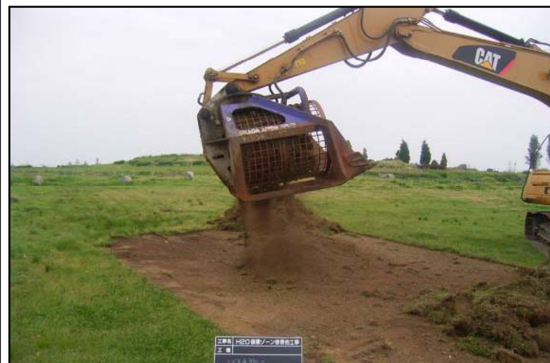
新技術工法による土砂と草の分別
