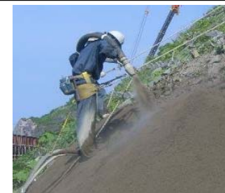
ローピングウォール 施工状況
