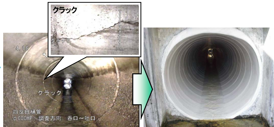
函渠内面からの補修（新技術）
