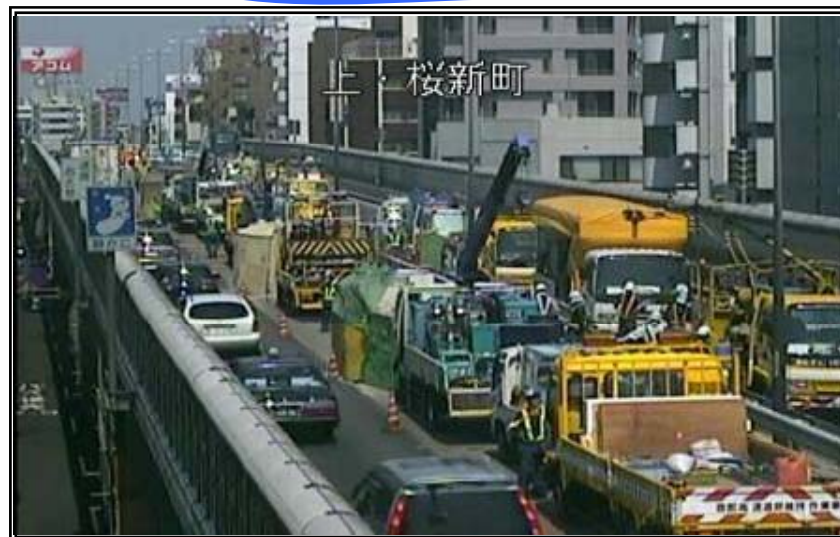
集中工事形式の施工(24時間連続規制)
