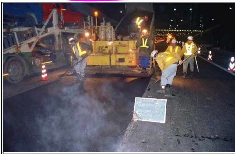
夜間交通規制による施工
