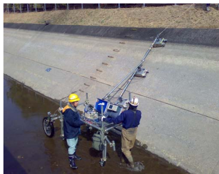
ライニング背面の地中レーダー探査による空洞調査
