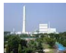
電力会社発電施設
