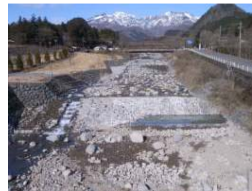
今回（高強度コンクリート）
