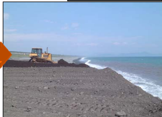
養浜の施工状況 (富士海岸吉原工区)
