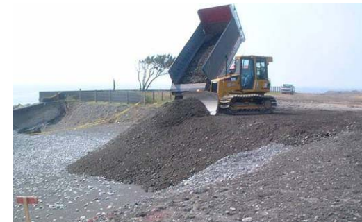
養浜の施工状況 (駿河海岸焼津地区田尻地先)
