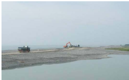
養浜材の採取状況 (大井川河口)
