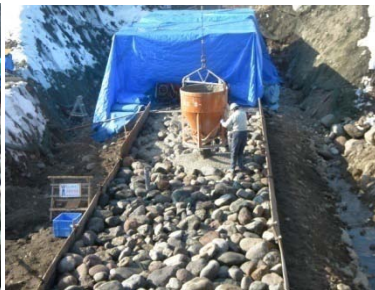
高流動コンクリート打設状況
