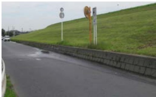
従来：現場打ち水路工+擁壁工
