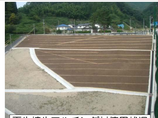
再生植生マルチング材使用状況
