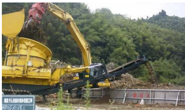
伐木材の粉碎状況
