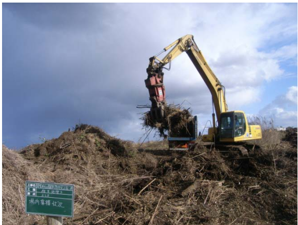
現場で発生した伐採木（従来は、廃棄物処理）
