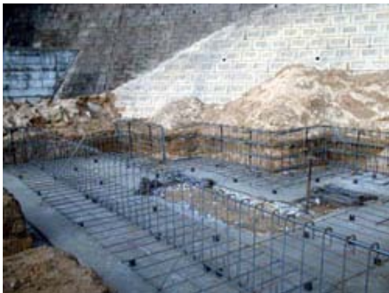
場所打コンクリート構造物
