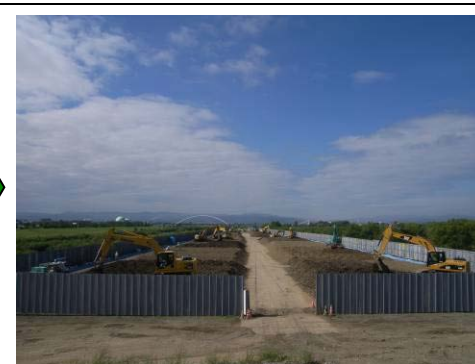
油汚染土改良
