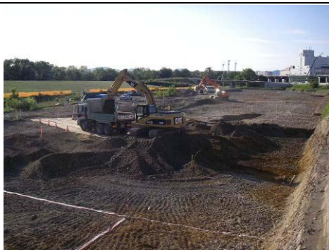
油汚染土掘削
