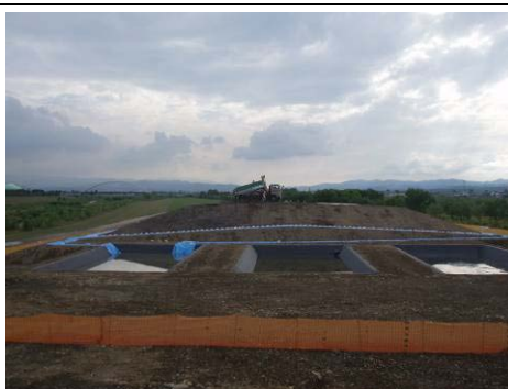
油汚染土仮置き
