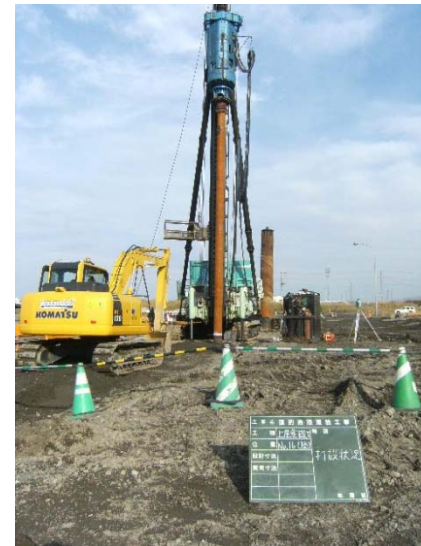
施工時の状況
