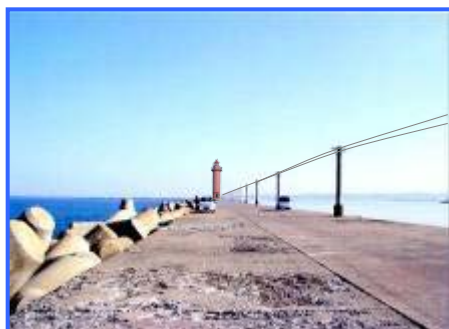
従来（配電線路）
