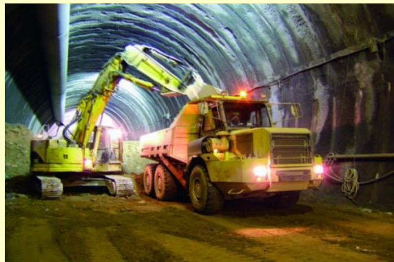
(従来) ダンプによる搬出
