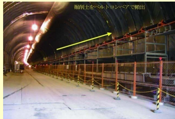
(新) ベルトコンベアによる搬出
