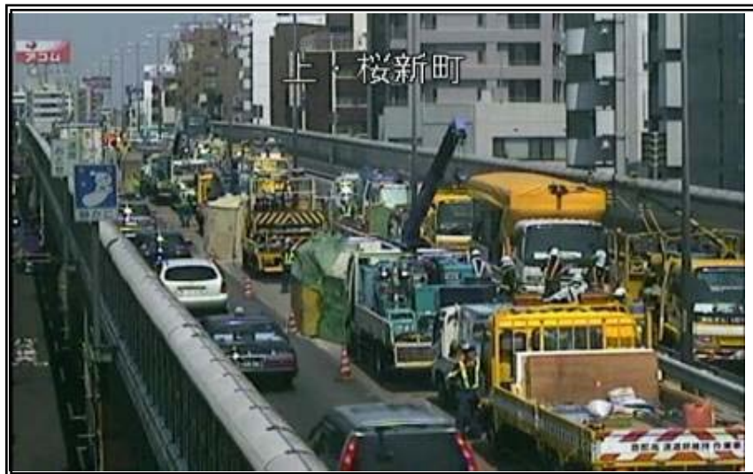
集中工事形式の施工(24時間連続規制)
