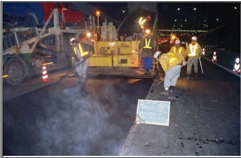
夜間交通規制による施工
