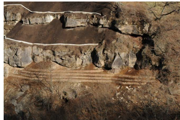
（今回）間伐材擁壁
