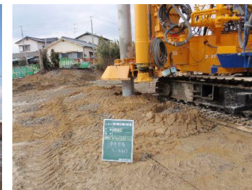
SAVEコンポーザー施工状況
