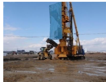
SAVEコンポーザー施工状況
