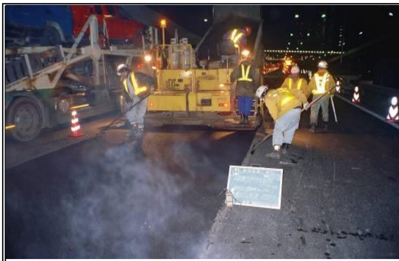
夜間交通規制による施工
