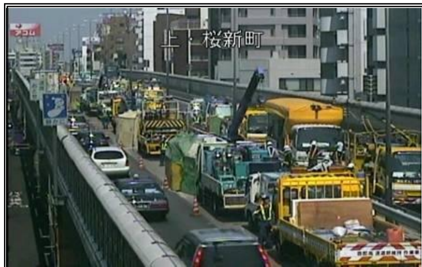
集中工事形式の施工(24時間連続規制)
