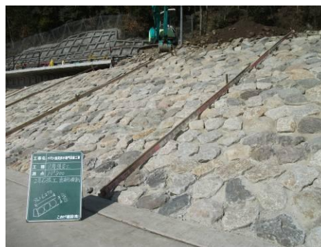
発生材（石）を再利用した護岸
