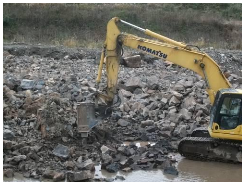
河道掘削において岩砕石が発生
