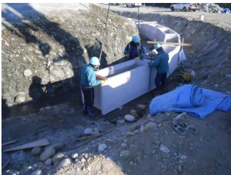
護岸基礎に2次製品を使用
