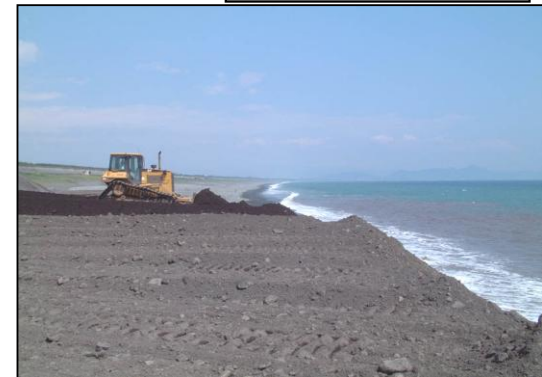
養浜の施工状況 (富士海岸吉原工区)
