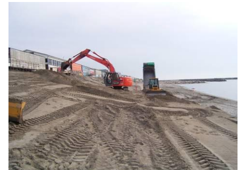
敷均し状況状 (海岸事業)
