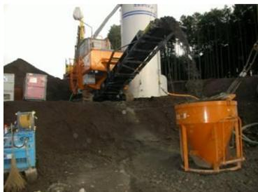
現場発生土砂とセメントを混合し、砂防えん堤の材料に使用
