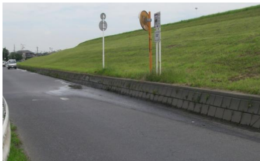
従来：現場打ち水路工 + 擁壁工
