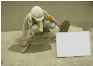
下地調整 モルタル金コテ押え
