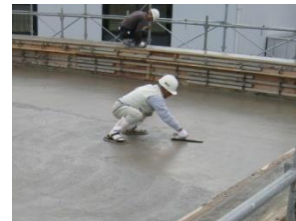
コンクリート打設後の コテ押え
