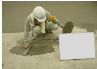
下地調整 モルタル金コテ押え
