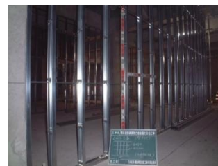
軽量鉄骨下地 ボード仕上壁
