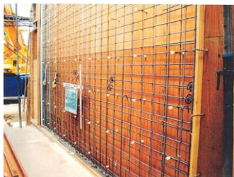
鉄筋コンクリート壁
