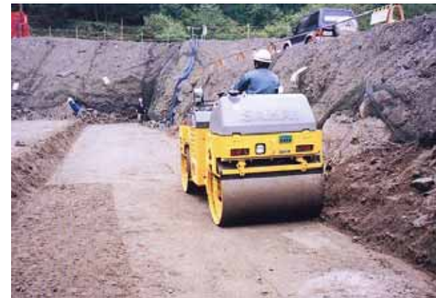
CSG材料の締め固め(振動ローラ)
