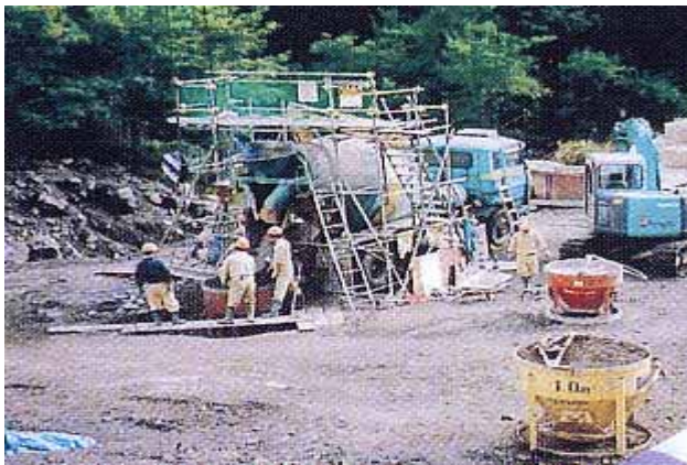
CSG材料の混合(アジテータ)
